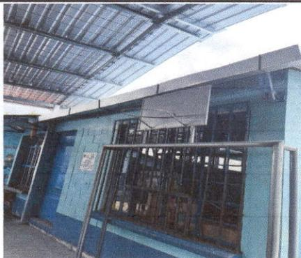
Foto 3: Colocación canales de metal
